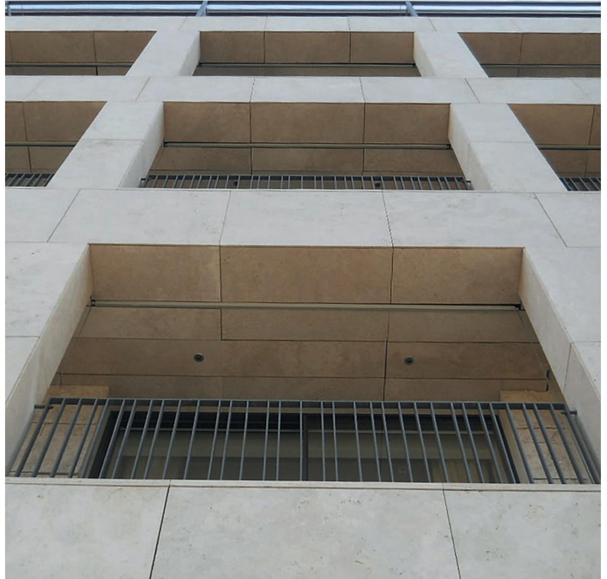
Detail of the balustrades and the metallic structure of the last floor Dettaglio dei parapetti e della struttura metallica dell'ultimo piano
