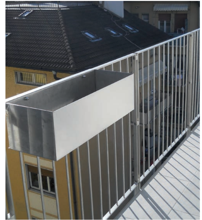
The flowerpots have also been made in AISI 316 stainless steel Anche le fioriere sono state realizzate in acciaio inox AISI 316
