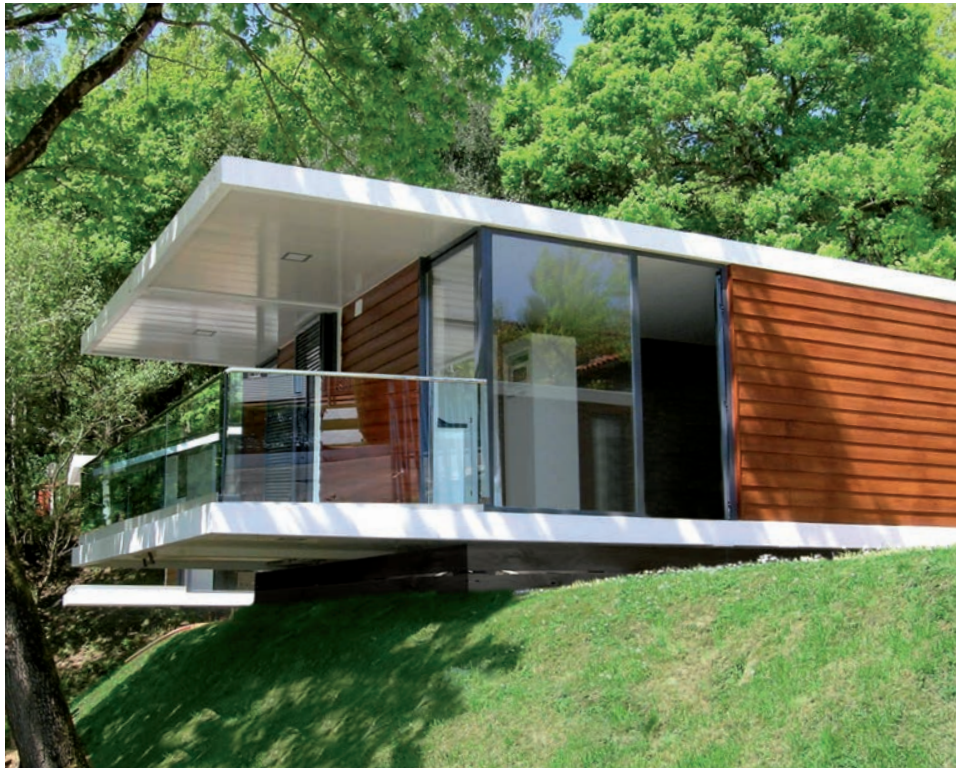
Details of the bungalows' outside railings Particolari dei parapetti esterni dei bungalow
