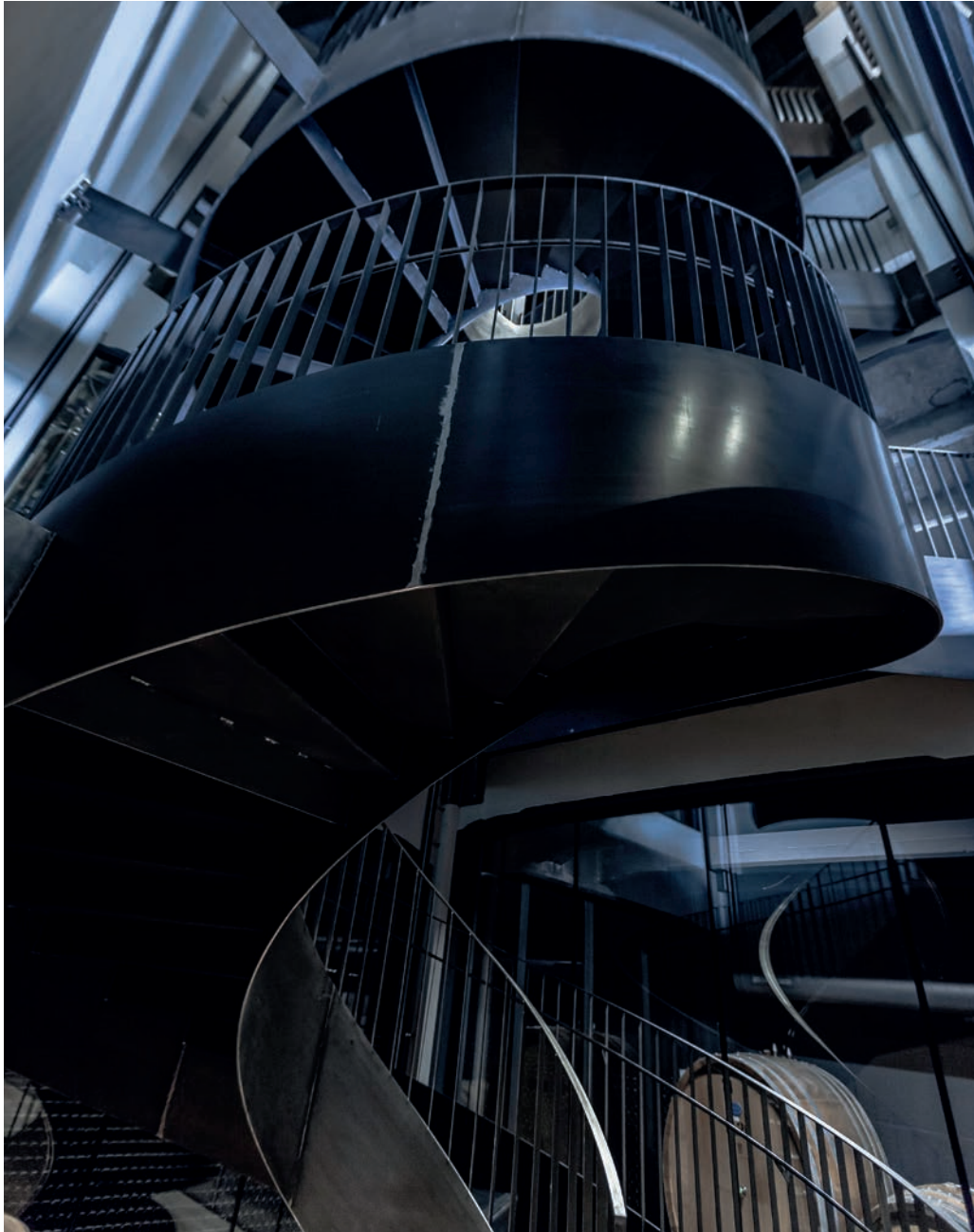
These railings were made in a flat 30 x 8 mm Questi parapetti sono stati realizzati in piatto 30 x 8 mm
