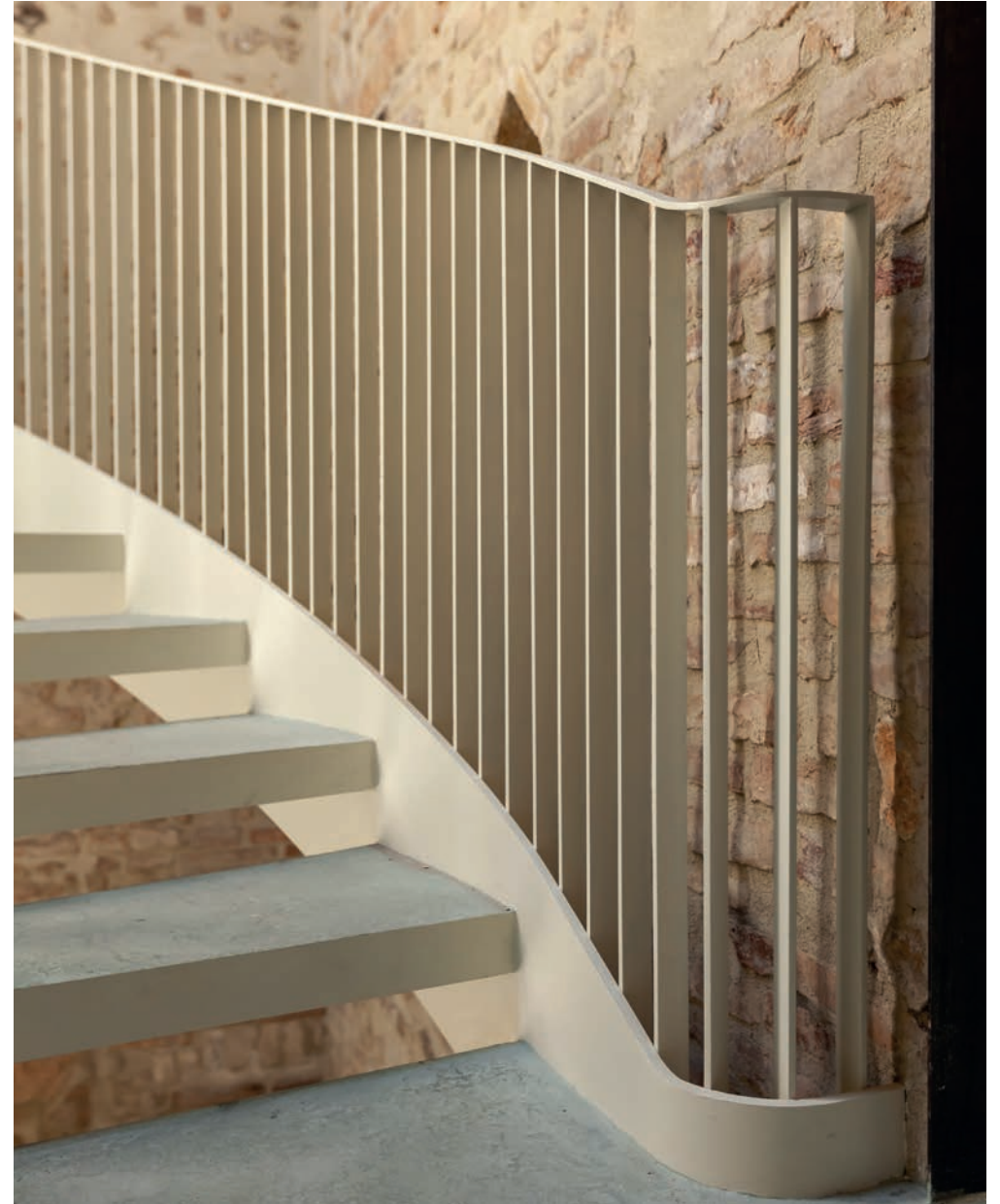
All the steps have been made creating for each one a concrete slab, poured into a matrix that faithfully reproduces the step Tutti i gradini sono stati realizzati creando per ognuno una gettata di cemento colato su una matrice che riproduce fedelmente il gradino
