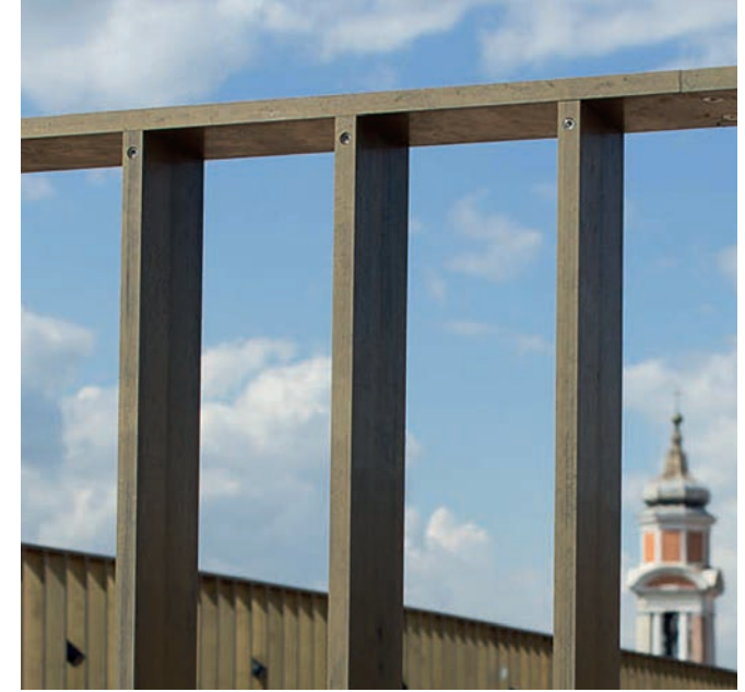
View of the railing system Vista del sistema di parapetto
