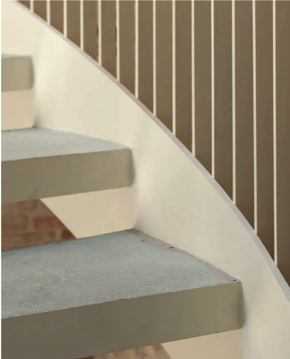
All the steps have been made creating for each one a concrete slab, poured into a matrix that faithfully reproduces the step Tutti i gradini sono stati realizzati creando per ognuno una gettata di cemento colato su una matrice che riproduce fedelmente il gradino
