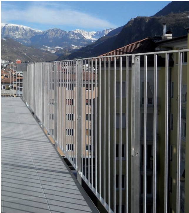
Detail of systems for attaching the panels in AISI 316 stainless steel Particolare dei sistemi di fissaggio dei pannelli in acciaio inox AISI 316
