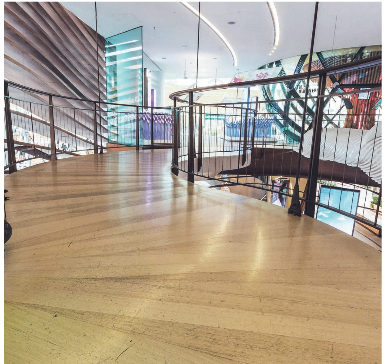
Detail of the railing on bridge linking. The infill was made with tensioned vertical wire ropes in stainless steel Particolare del parapetto sul ponte di collegamento. Il tamponamento è stato realizzato con funi verticali di acciaio inox tensionate
