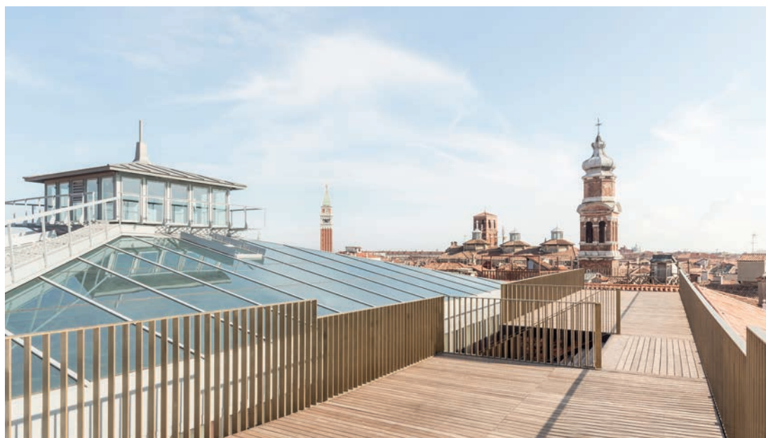
The railing in natural brass flat bar 70 x 10 mm on the covered roof-terrace Il parapetto in piatto di ottone naturale 70 x 10 mm sull'altana
