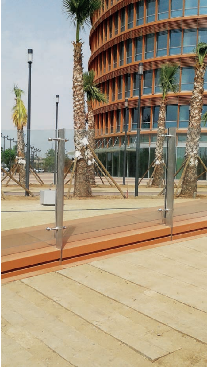
Post realized with a blade AISI 316 satin finish stainless steel. Piantone realizzato con una lama di acciaio inox satinato AISI 316.
