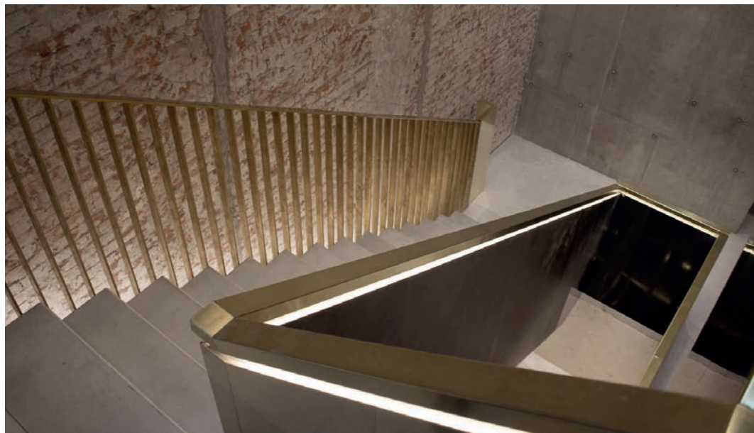
Detail of the handrail on the paneling side with insertion Led Particolare del corrimano sul lato pannellato con inserimento Led
